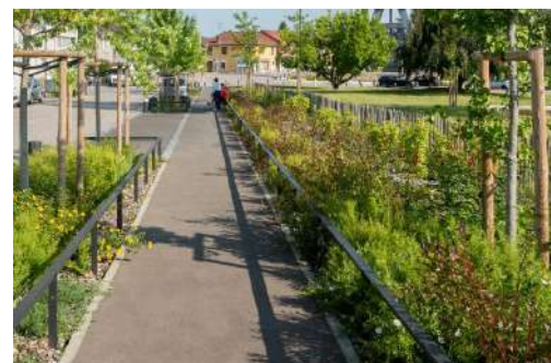
Protection avec des barrières basses en métal, doublées d'une bordure en bois sur la partie du parc.
