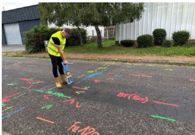
Marquage au sol signifiant la diversité de réseaux, parfois en abondance sous nos pieds.
