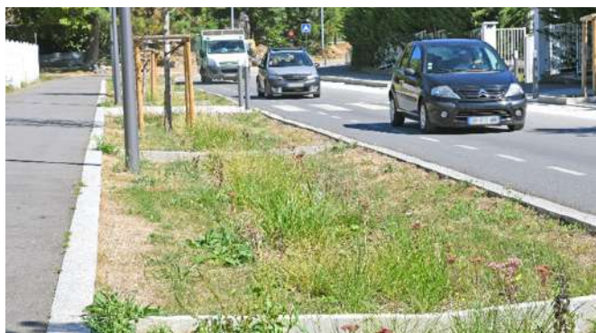
Noue avec des bordures au même niveau que la voie.
