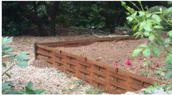
Protection avec un plessis en acier corten.
